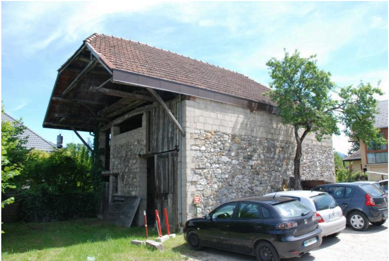
Grange avec monte-foin à quatre câbles (2016 A6 1113), non repérée.
