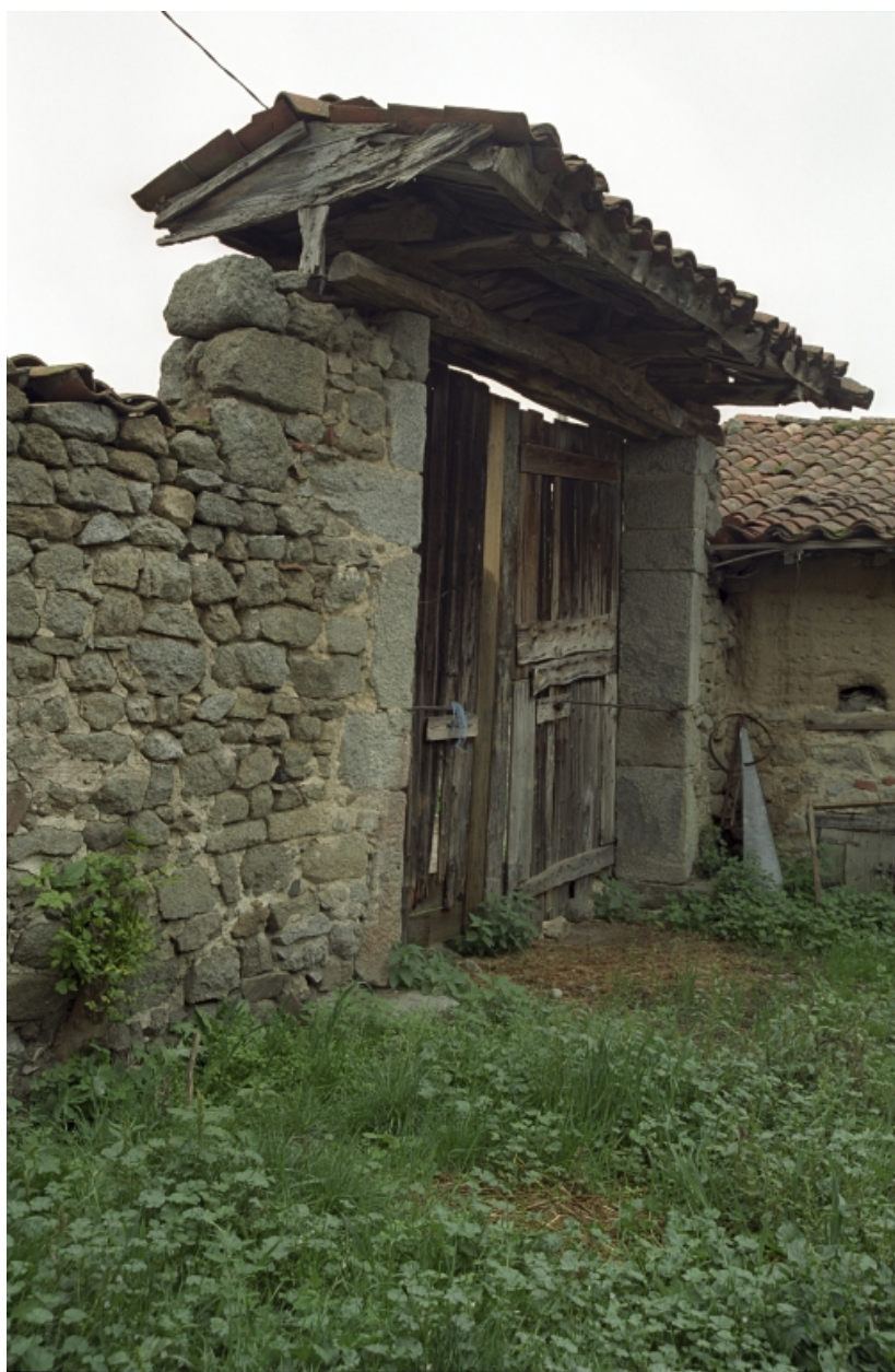
Vue du portail depuis la cour.
