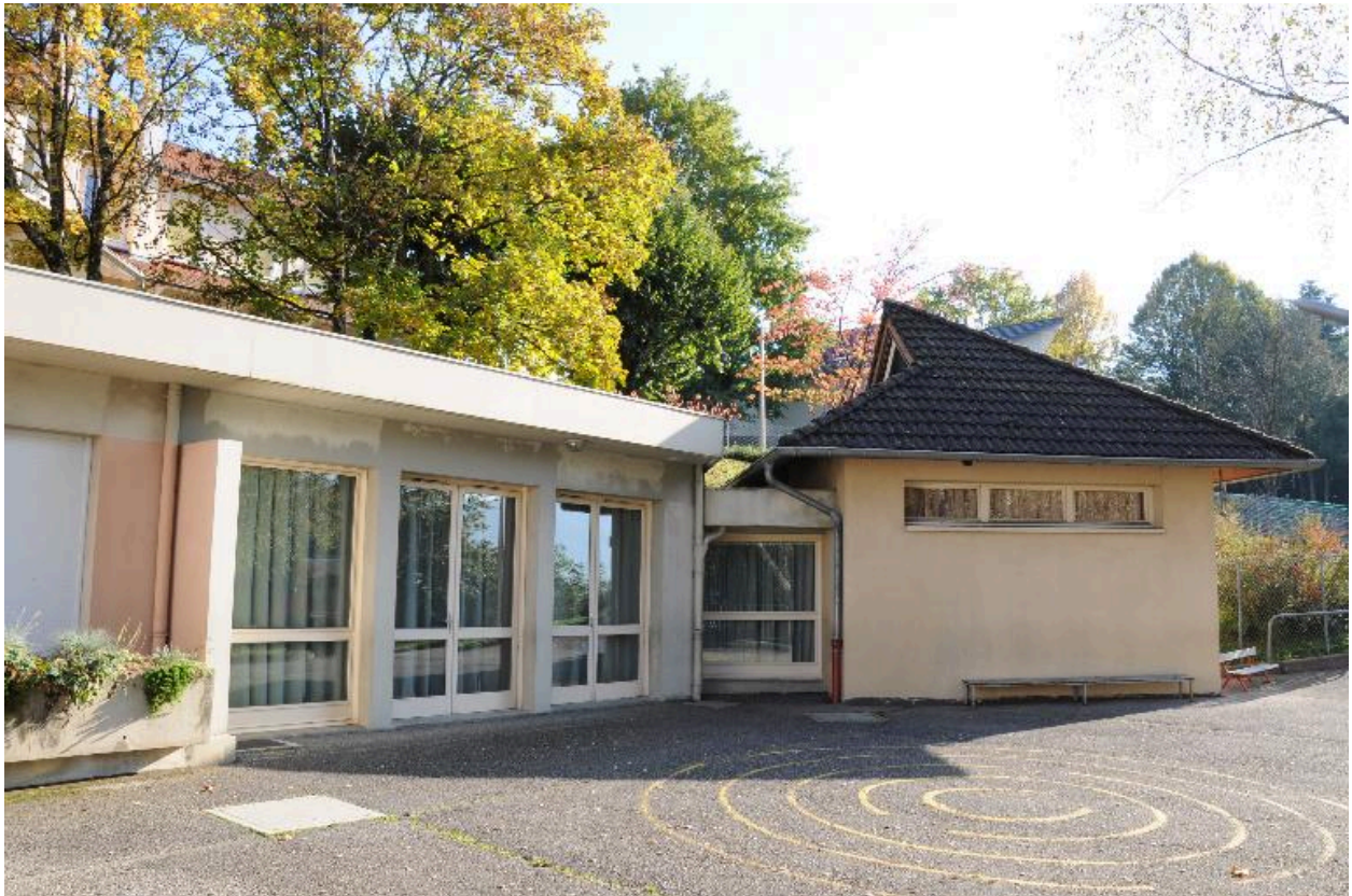
Salle de motricité et salle de rangement à l'est
