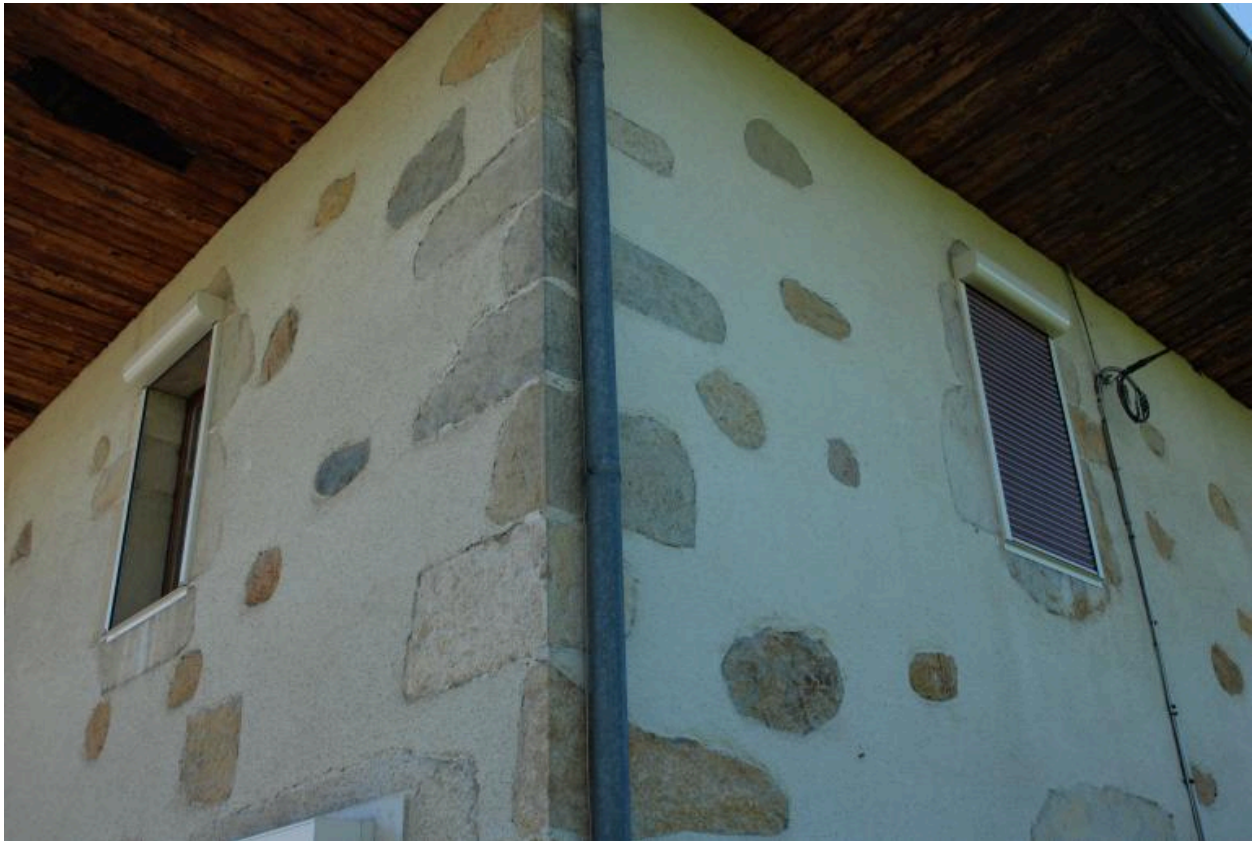
Détail de l'angle (enduit en surépaisseur).
