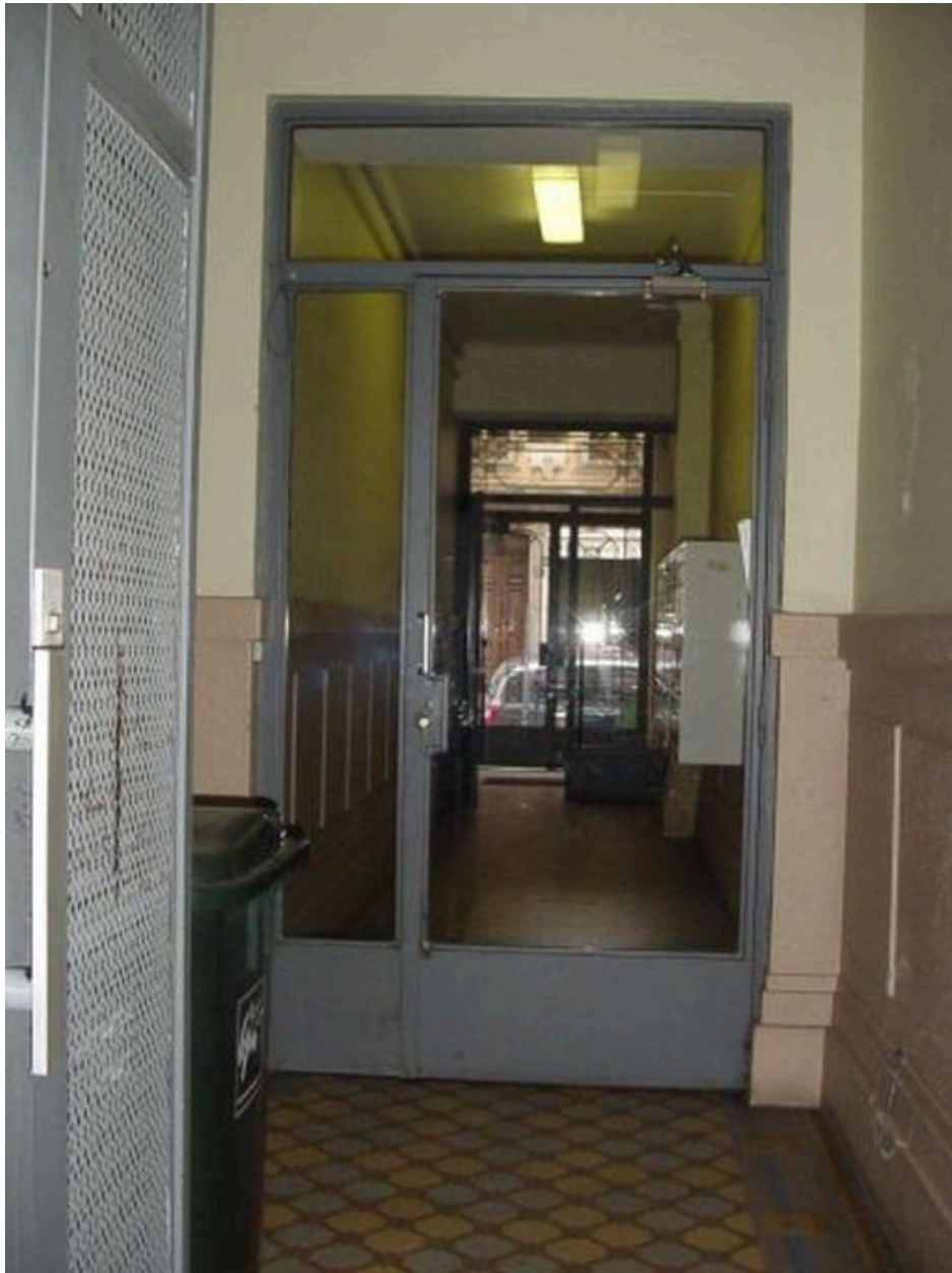
Vue de l'entrée en enfilade
