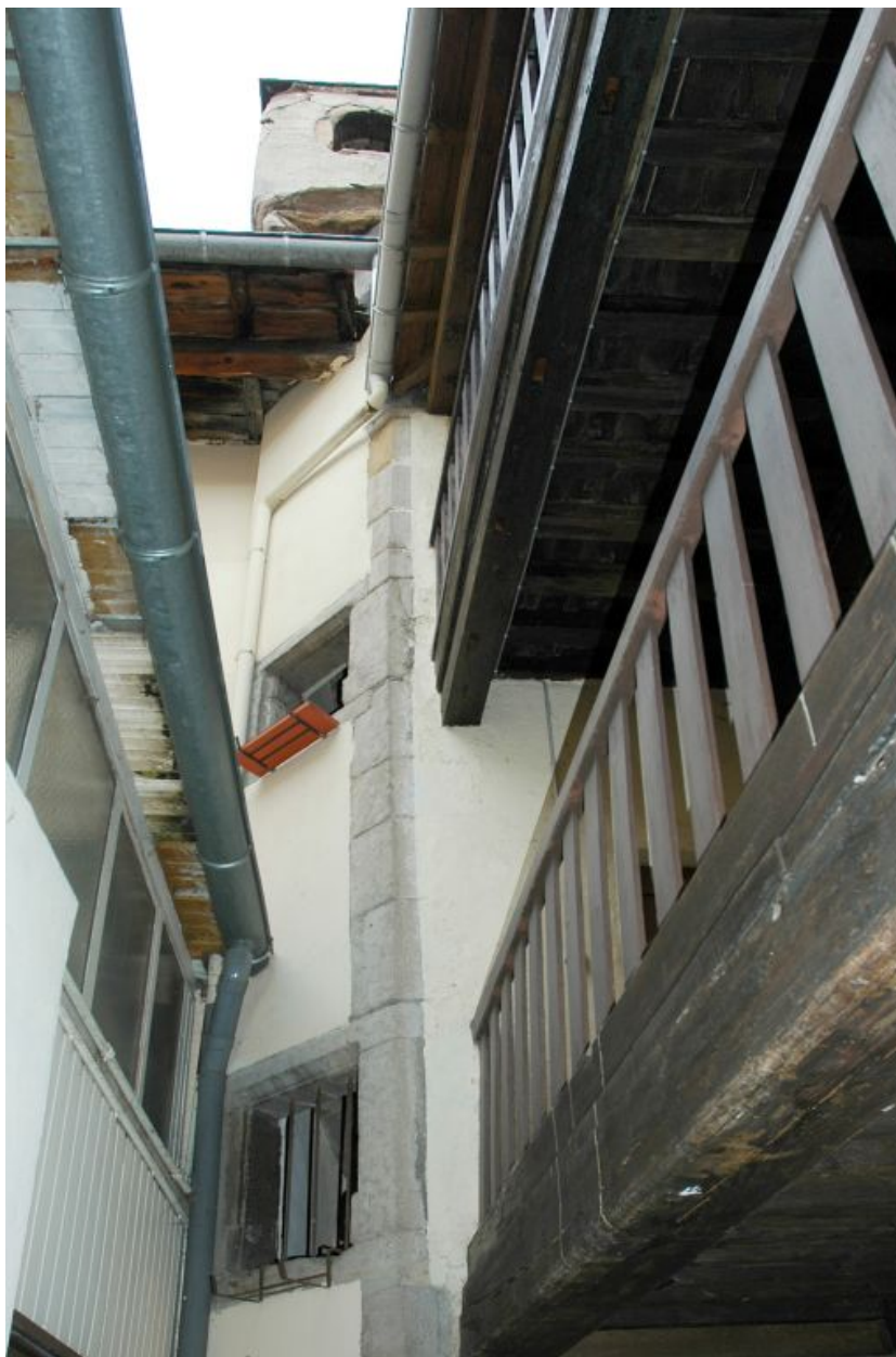
Vue partielle sur cour : galerie en bois reliant les deux corps de bâtiment et vue de la lanterne terminant le sommet de l'escalier.
