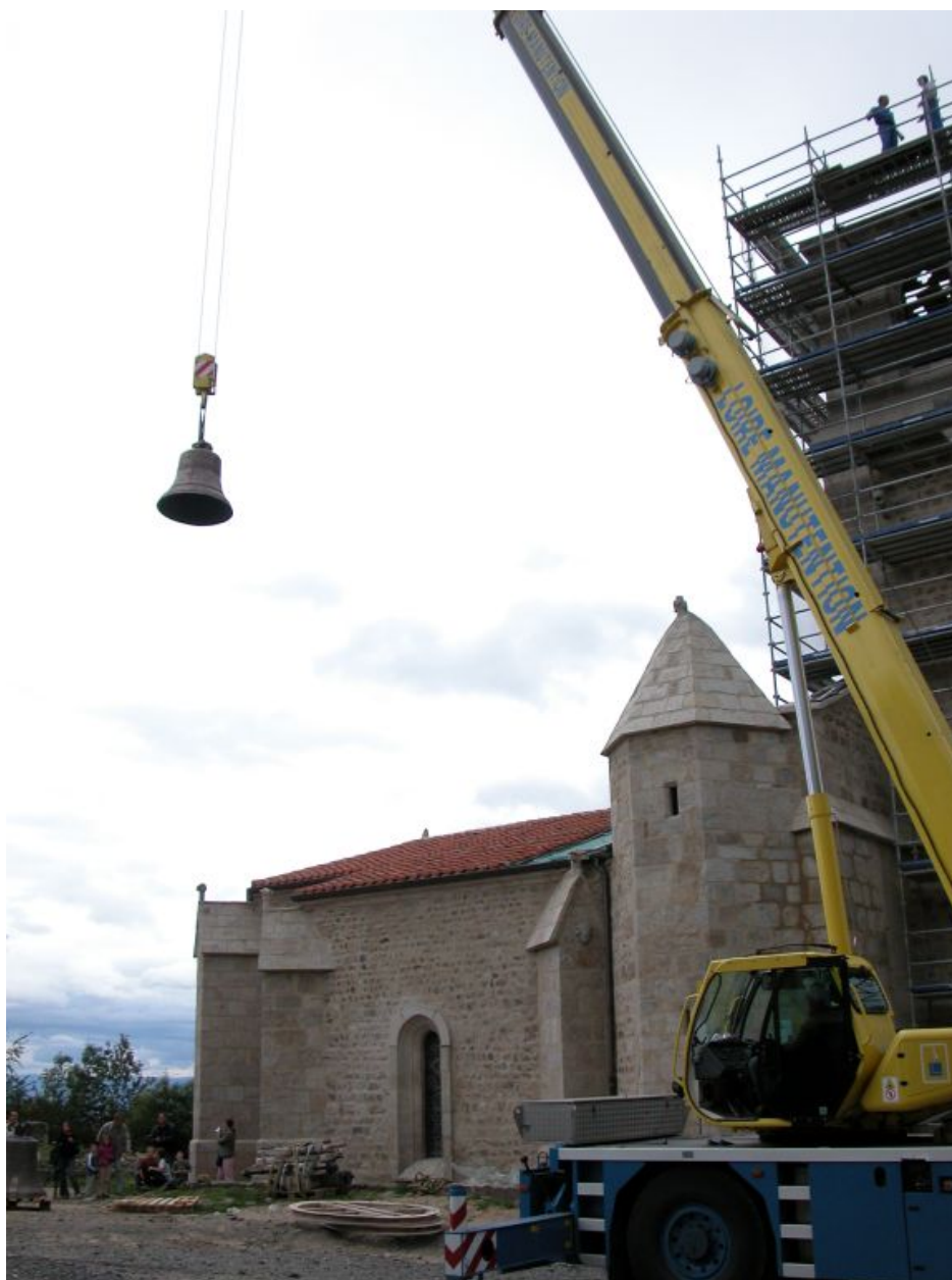
Cloche (n°1) élevée à l'aide d'une grue.
