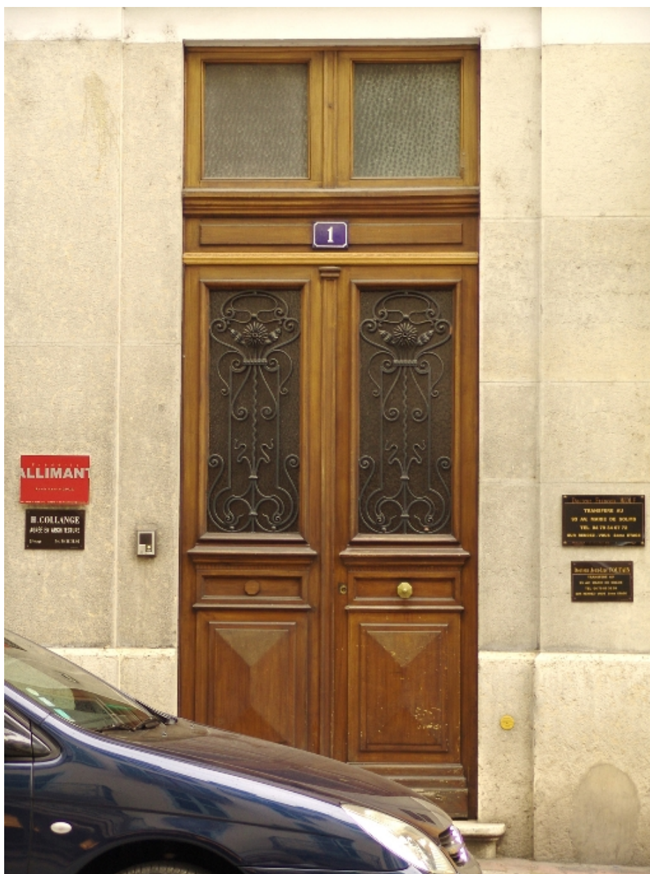
Détail de la porte
