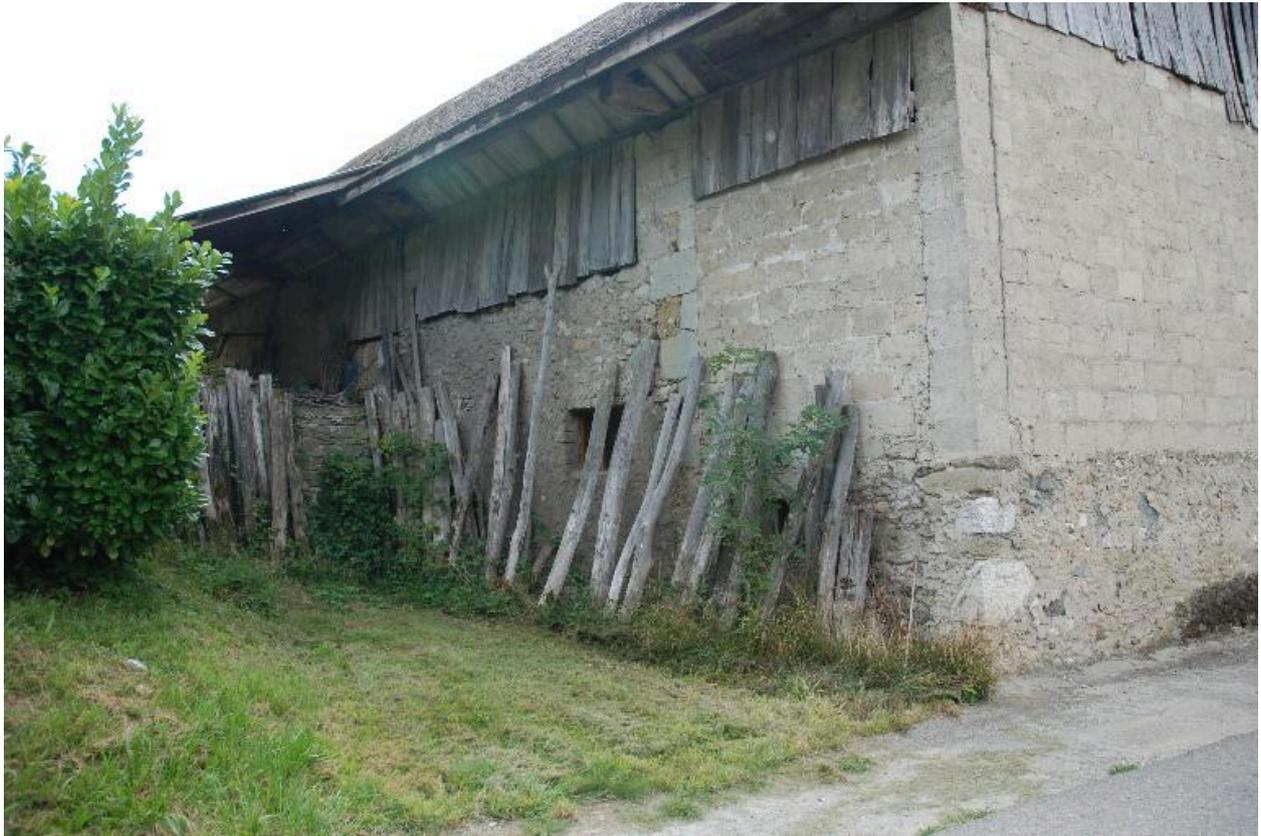
Vue arrière : murs en parpaing de béton plein.
