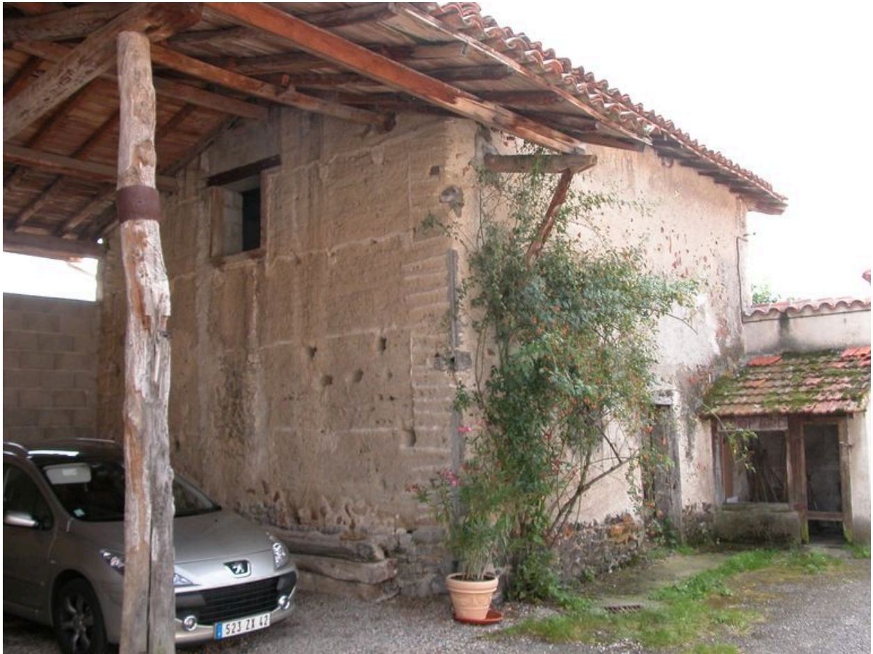
Vue du bâtiment sud-ouest depuis l'intérieur de la cour.
