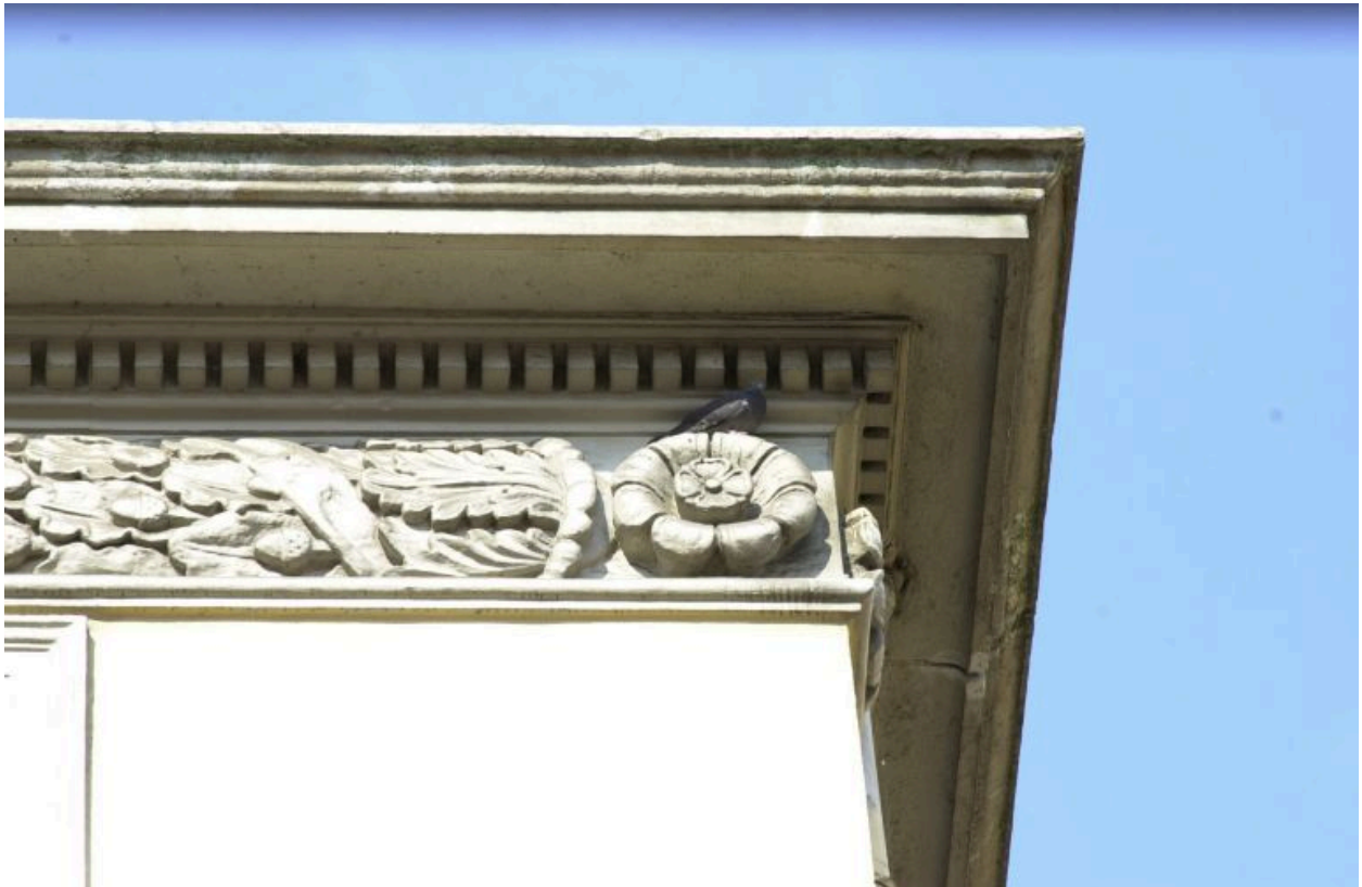
Façade principale, détail de la corniche
