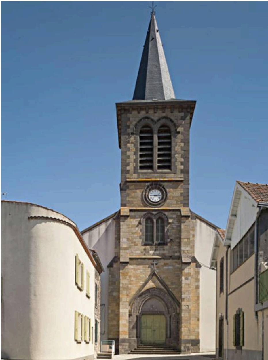
Vue générale de la façade occidentale.
