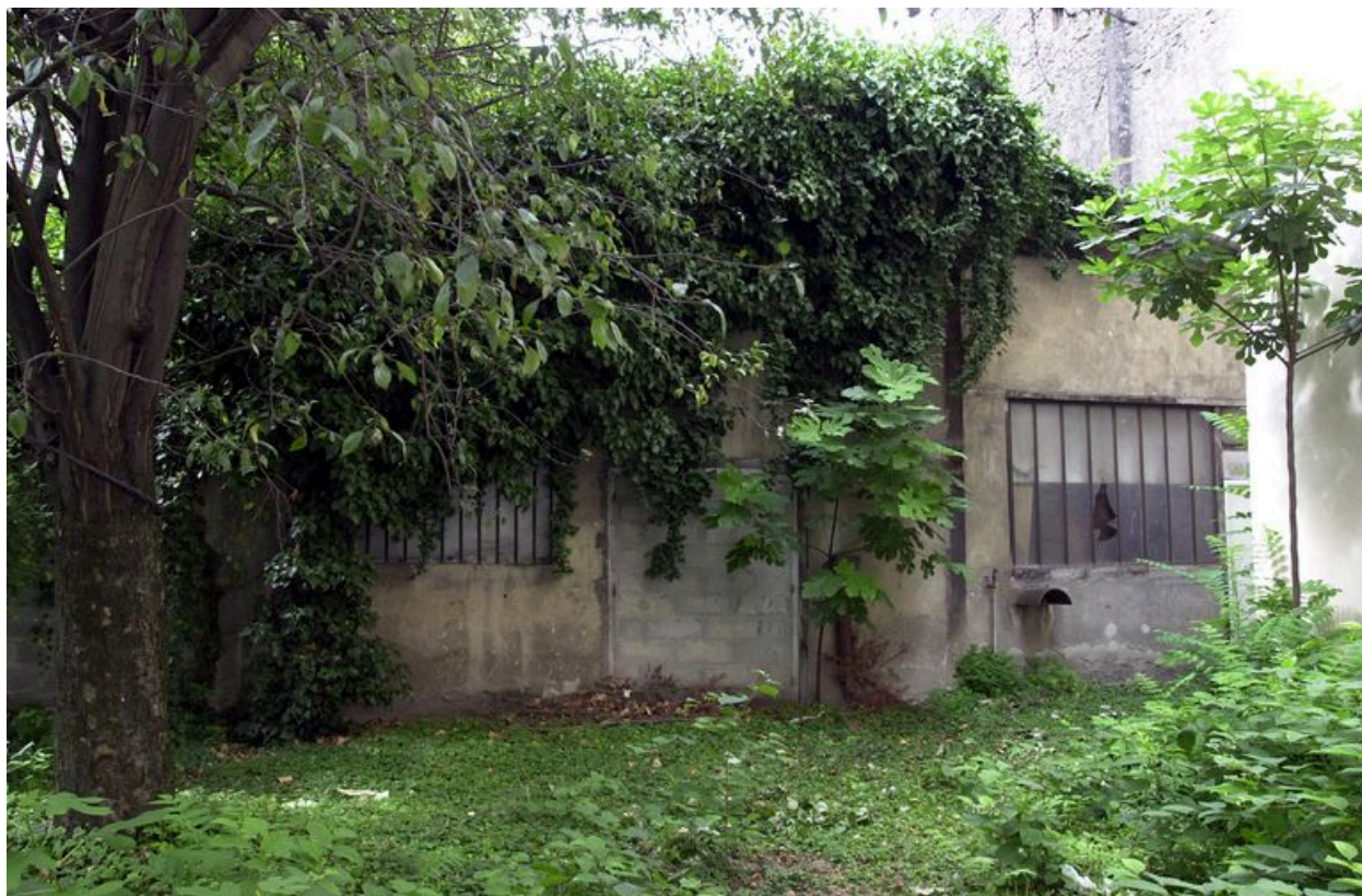
Ateliers, façade nord, côté jardin
