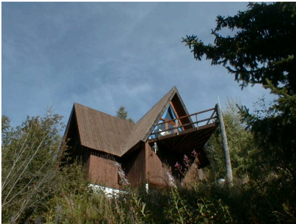
Chalet n° 15. Vue d'ensemble
