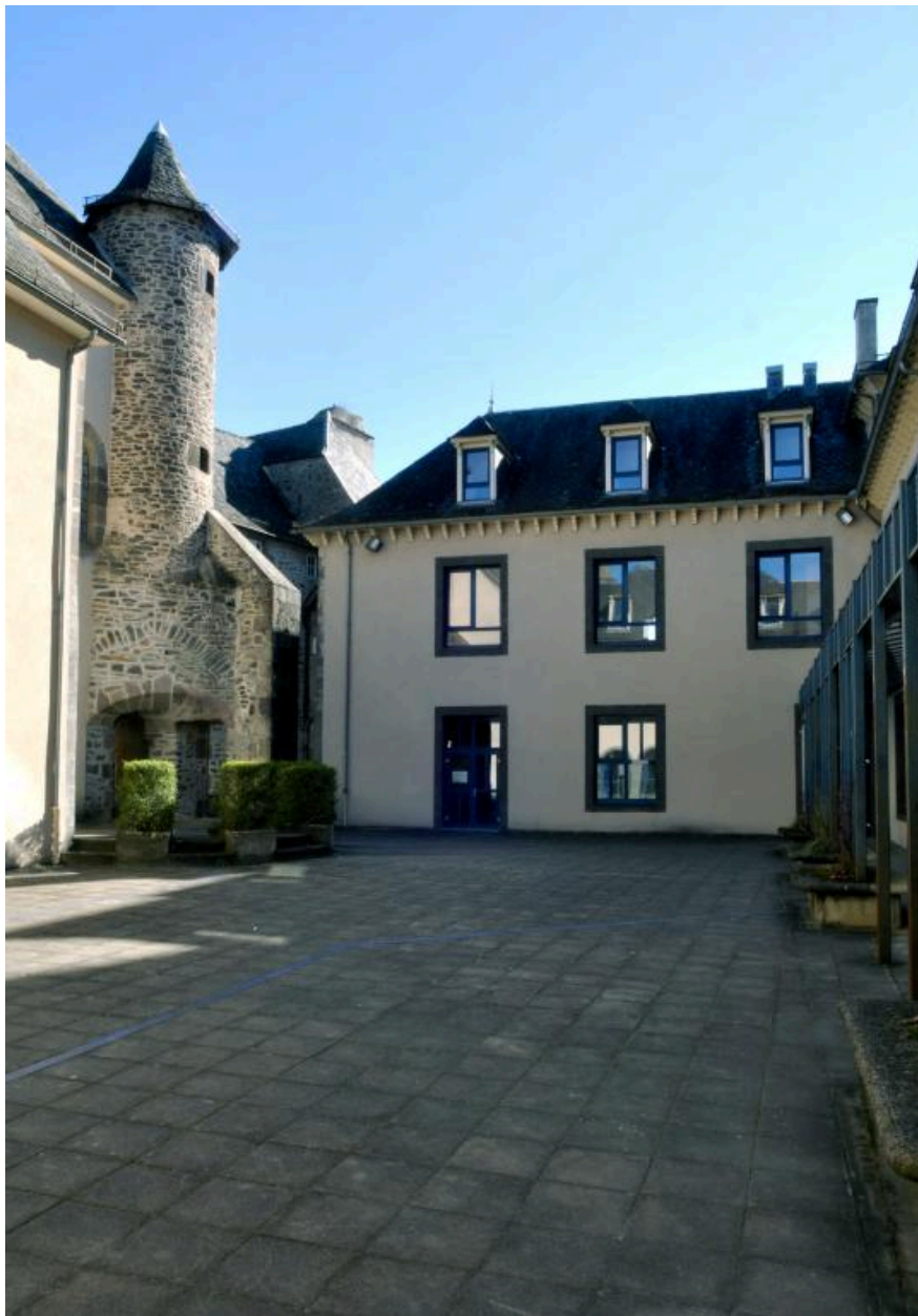
Cour sud, vue depuis le nord-ouest
