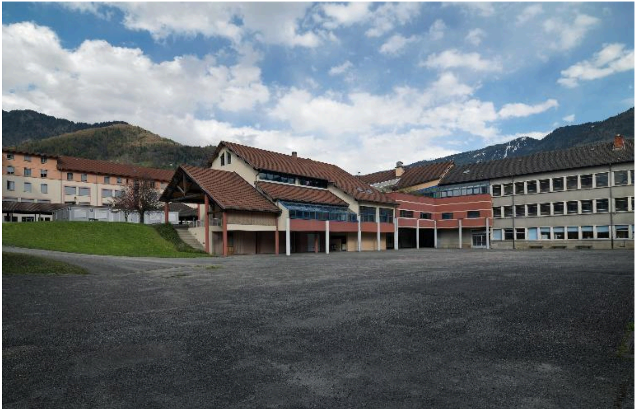
Bâtiment H et cour basse, vue d'ensemble depuis le sud-est
