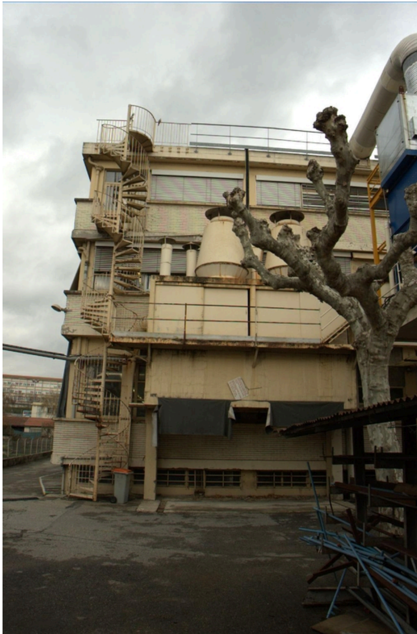
Façade sud : escalier de secours
