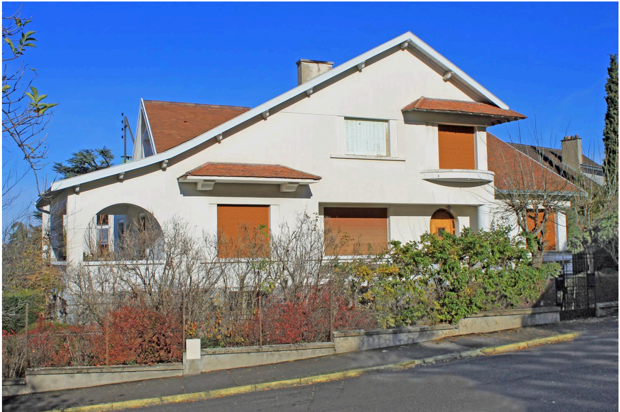
Royat, la maison M. vue depuis l'avenue Jean-Heitz (façade principale sud).
