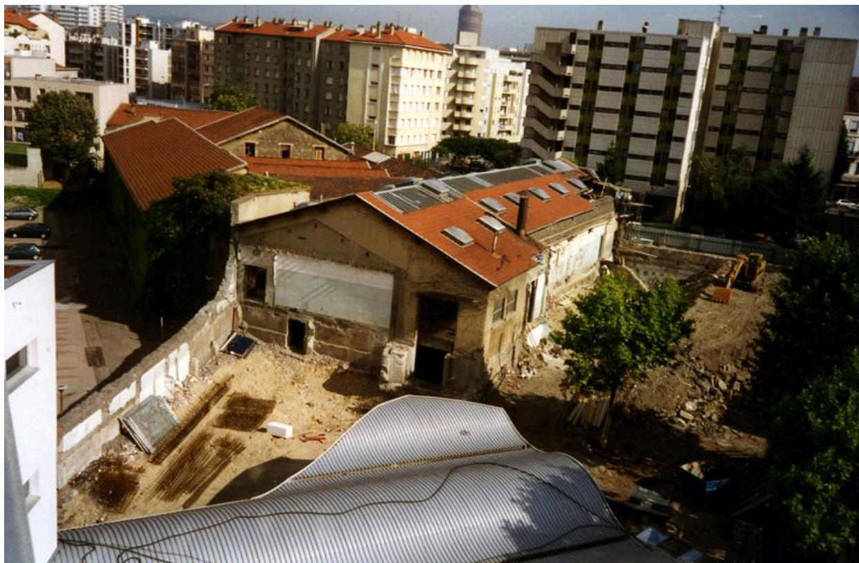
Vue des travaux dans la cour depuis le bâtiment A, 1995
