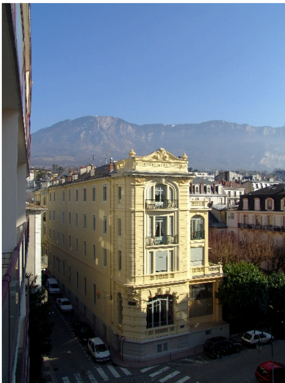
Aile Béatrice : vue générale prise de l'ouest
