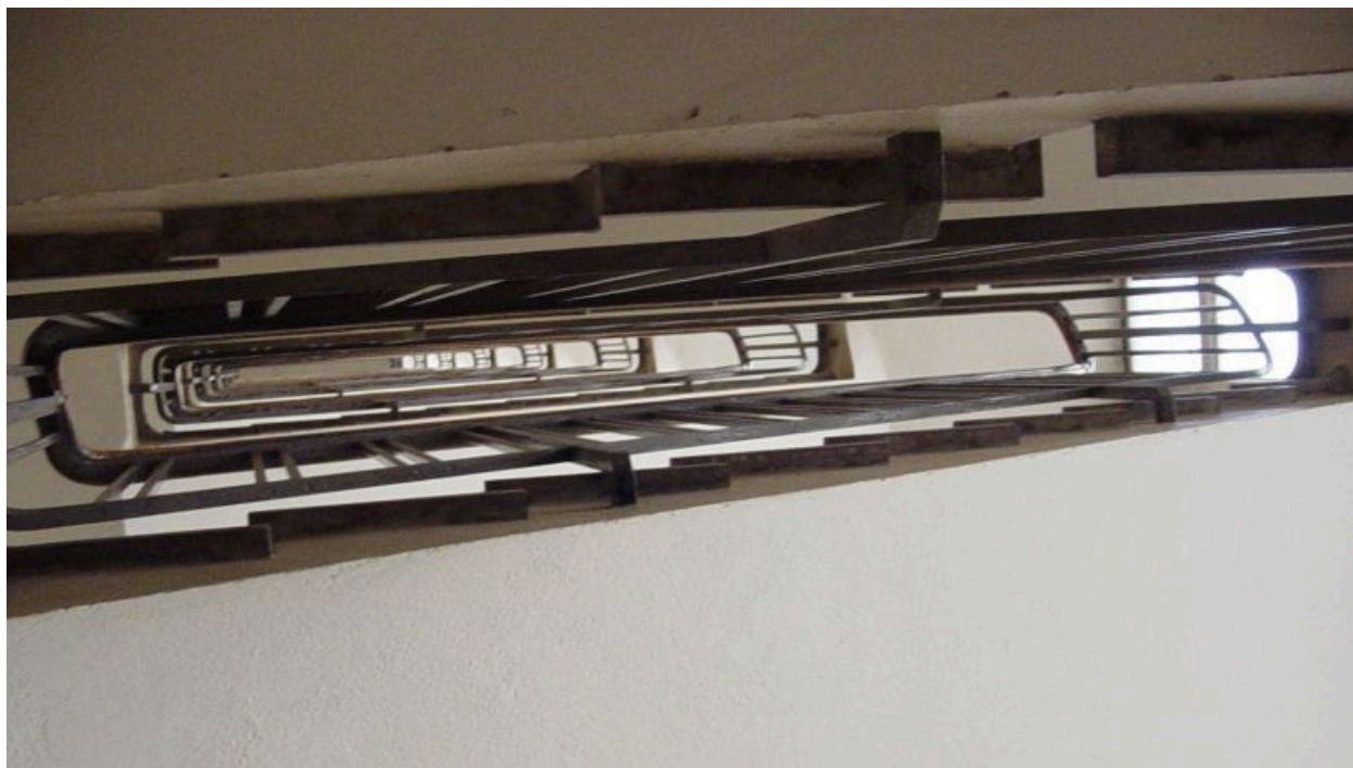
Cage d'escalier vu de dessous
