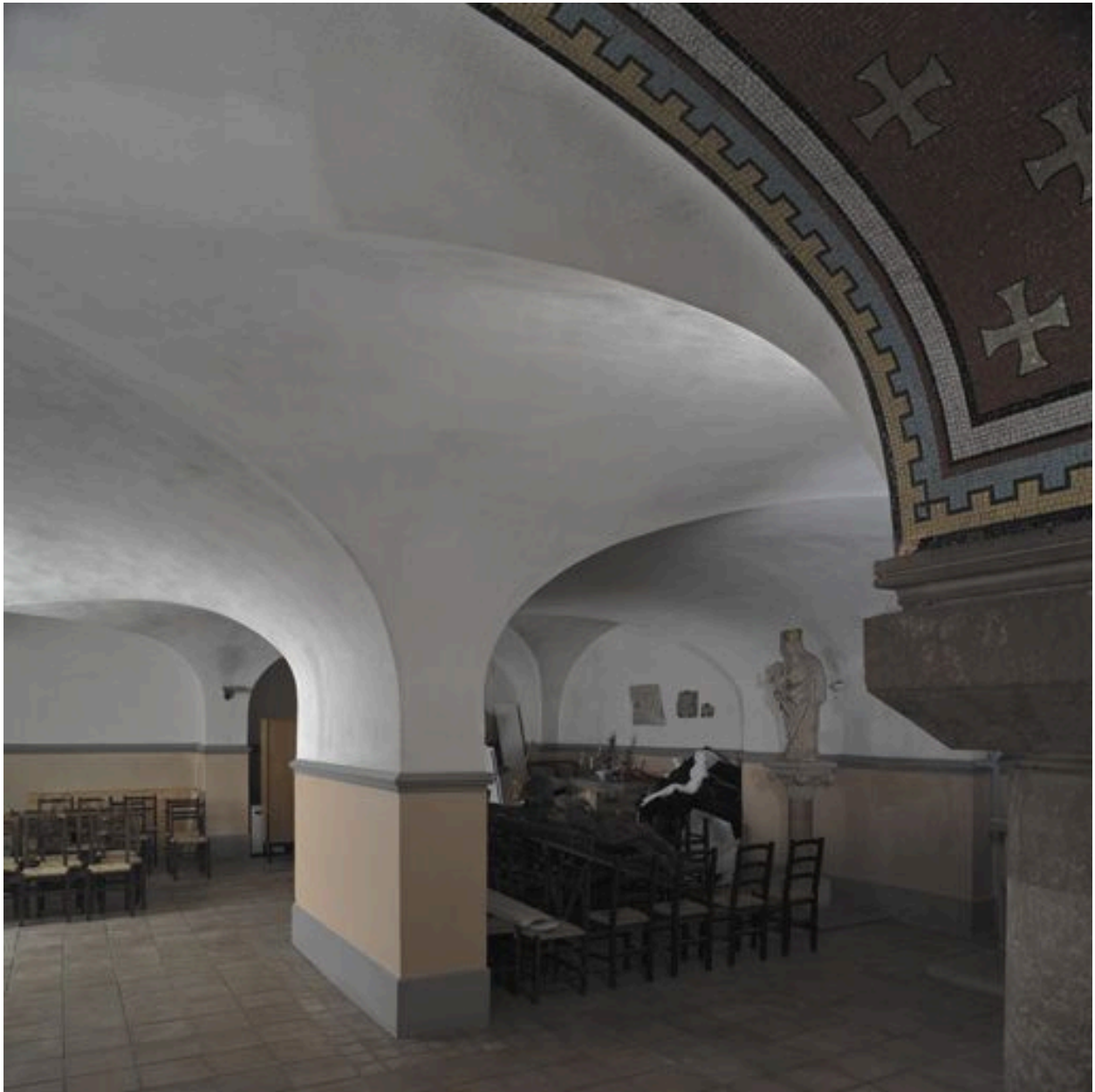
Crypte, les deux dernières travées de la nef vues depuis le chœur
