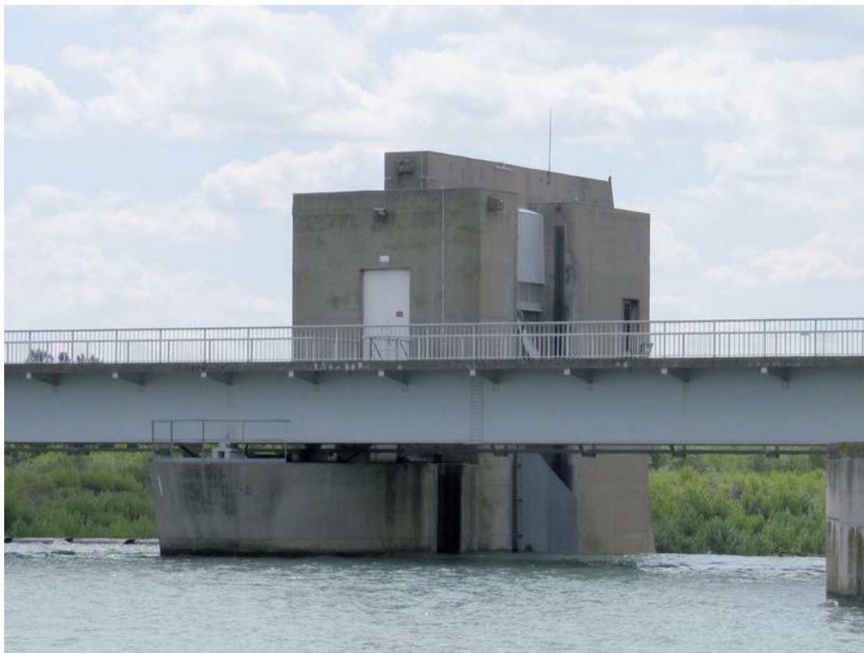
Pont de service, face amont (depuis la rive droite)
