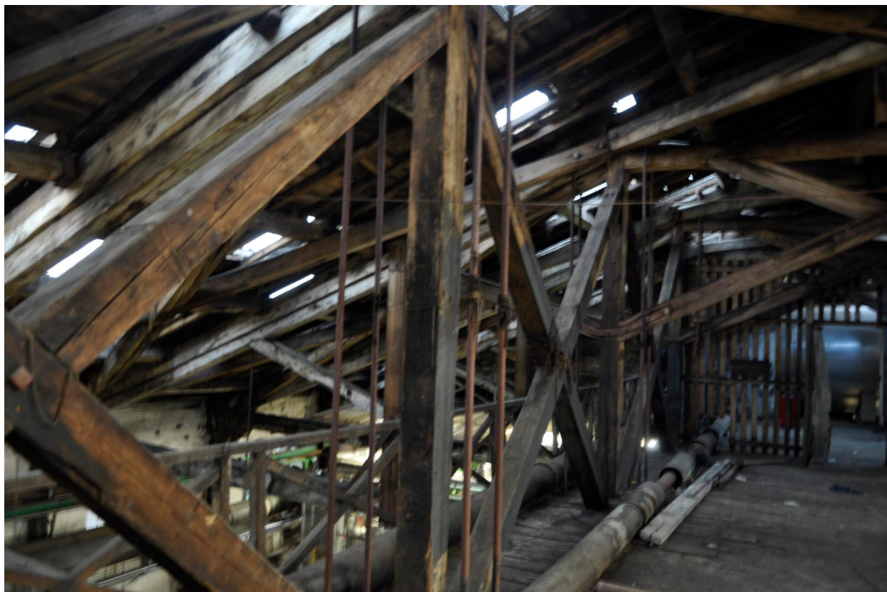
Détail charpente bois
