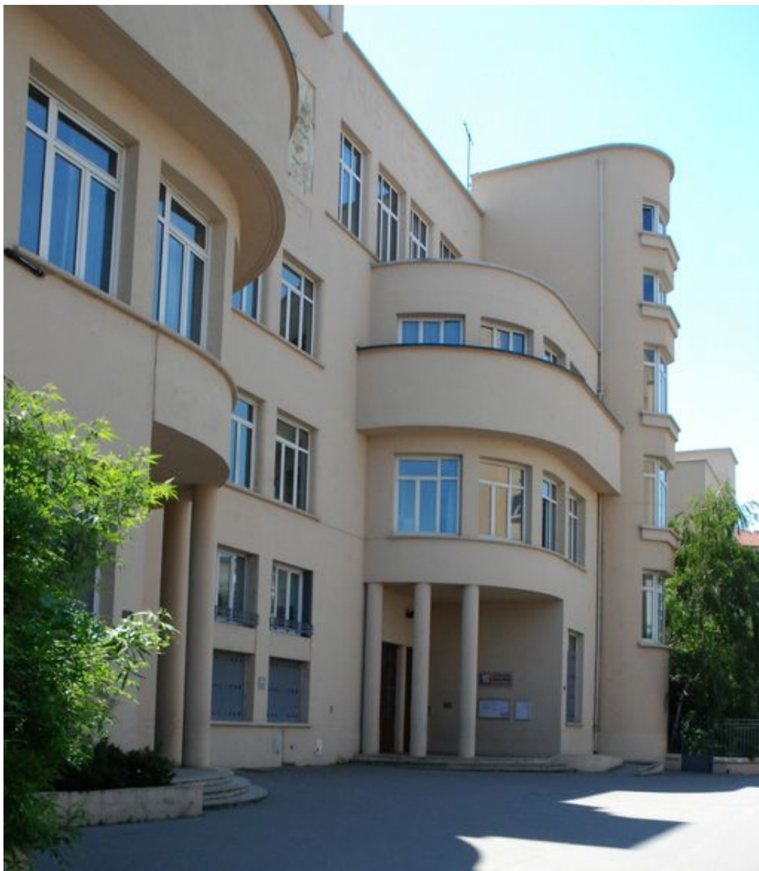
Vue sur l'entrée latérale sud
