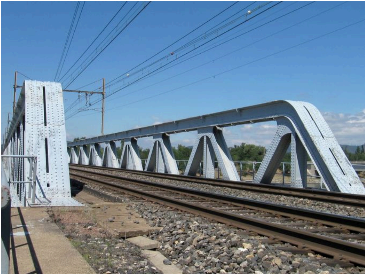
Tablier, vue partielle : voie ferrée (depuis la rive droite)
