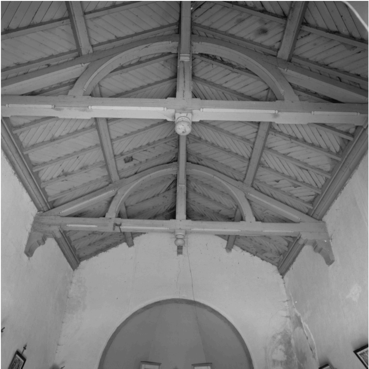
Vue de la charpente.
