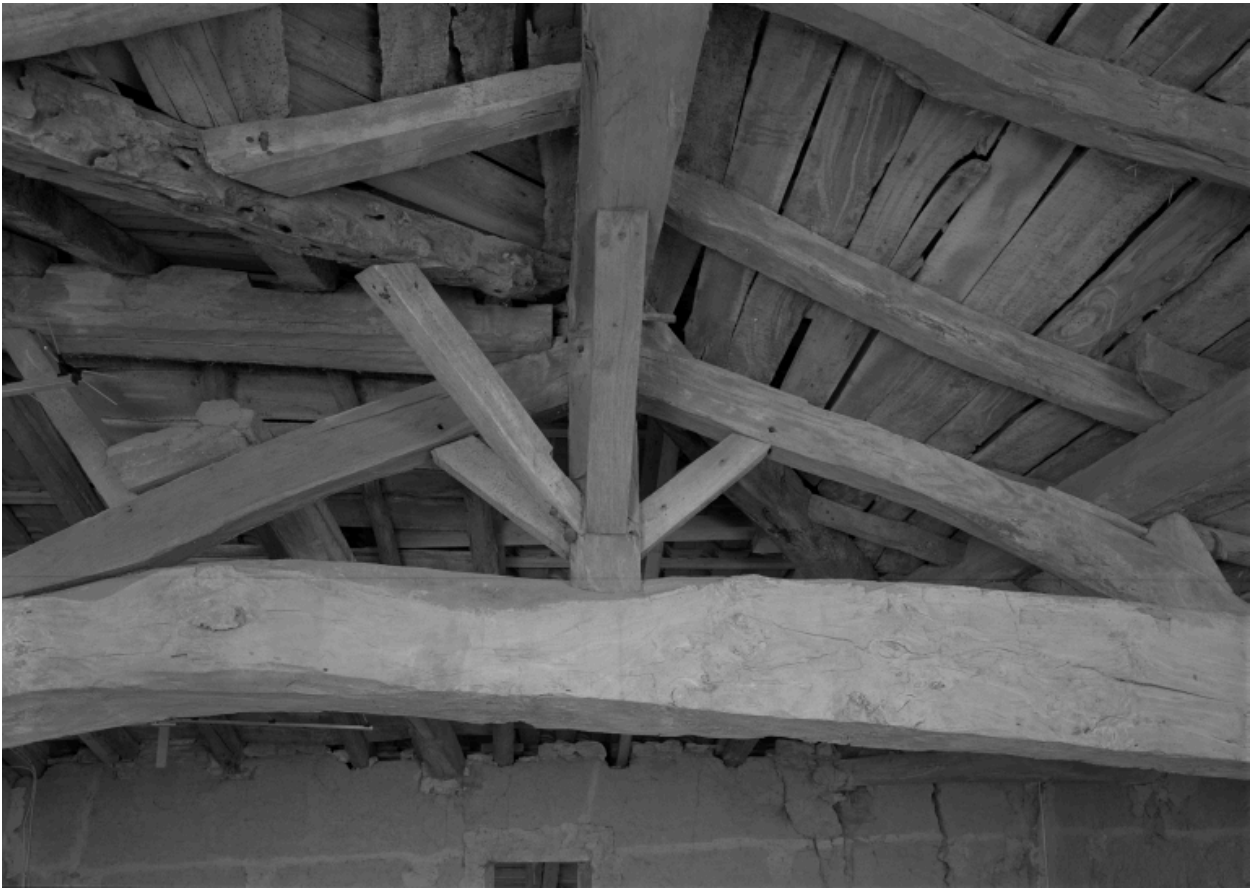
Charpente dans un grenier : détail d'une ferme.
