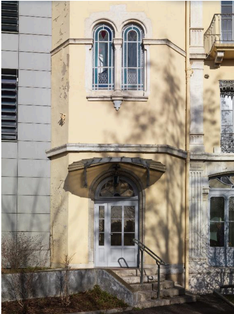
Vue rapprochée de l'élévation sud : rez-de-chaussée et premier niveau de la tour d'escalier
