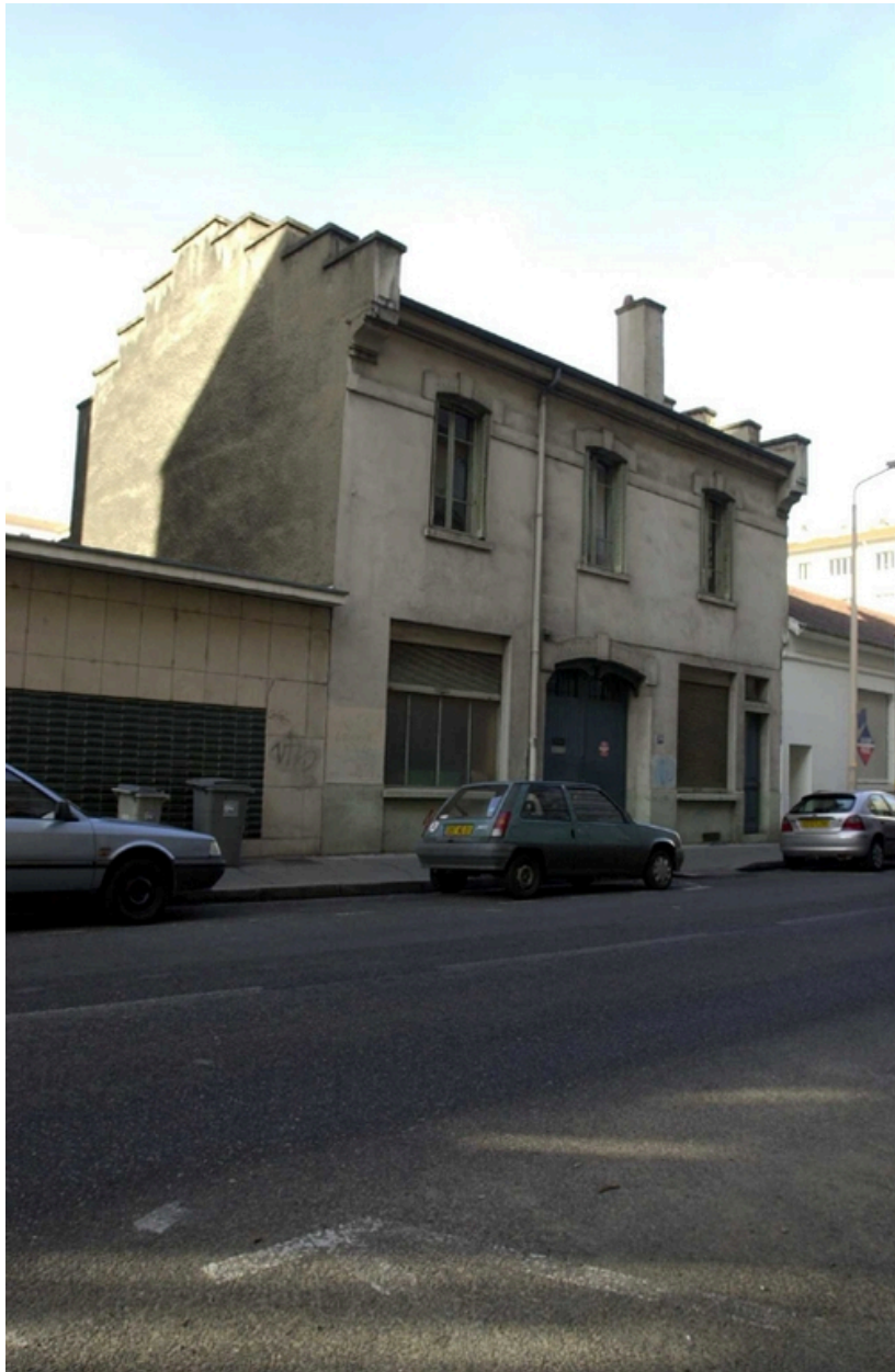
Vue sud, bâtiment administratif
