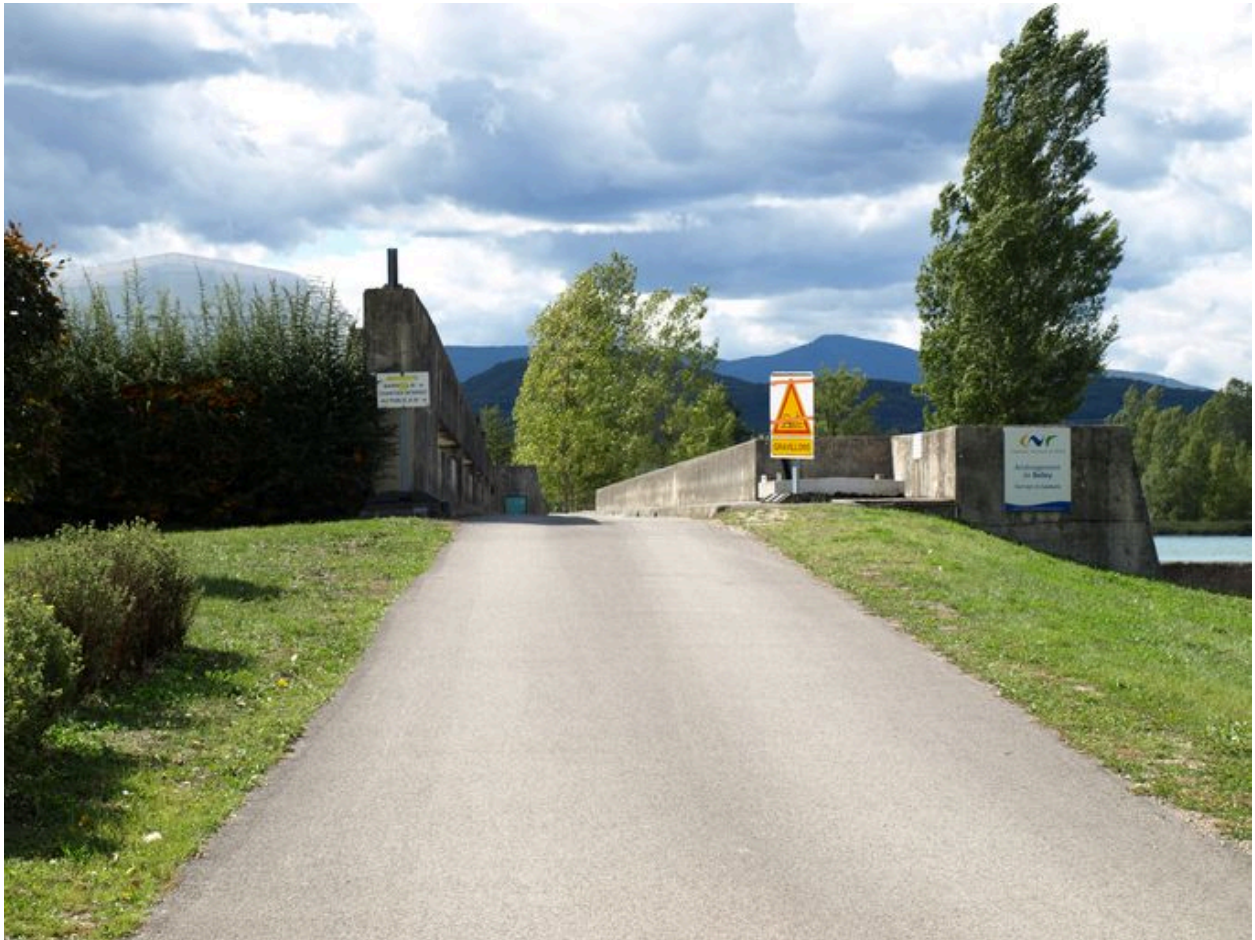
Vue de la chaussée
