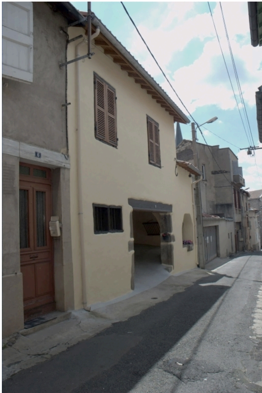
Îlot 6. 11 Novembre (rue du) 08. Vue générale de la façade sur rue
