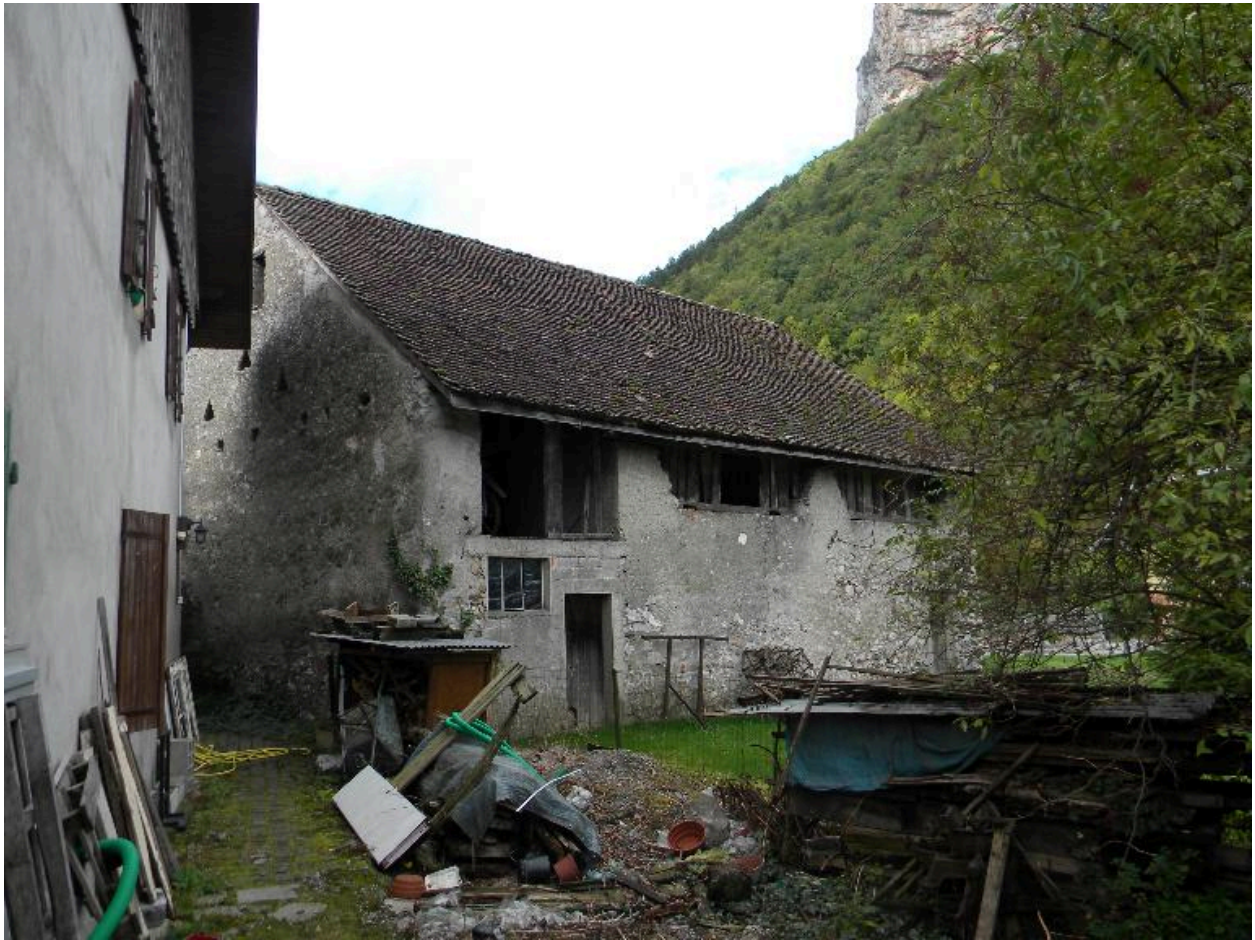
Vue de la façade est.
