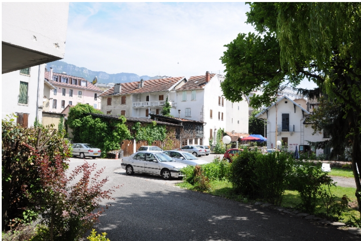
Vue générale depuis l'arrière
