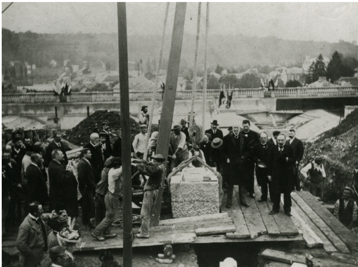
Pose de la première pierre
