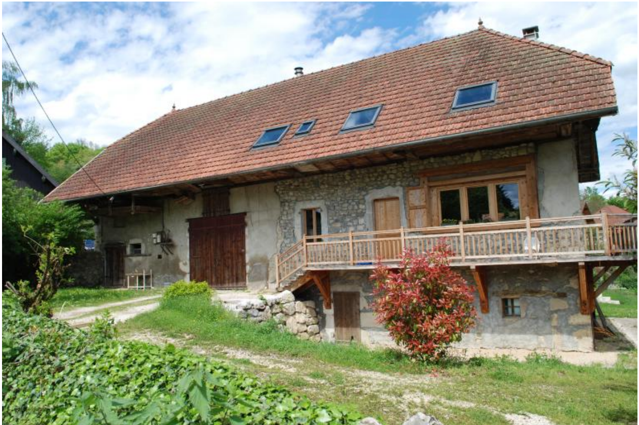
2015 E3 243, Lachat, ferme. Vue d'ensemble de face.
