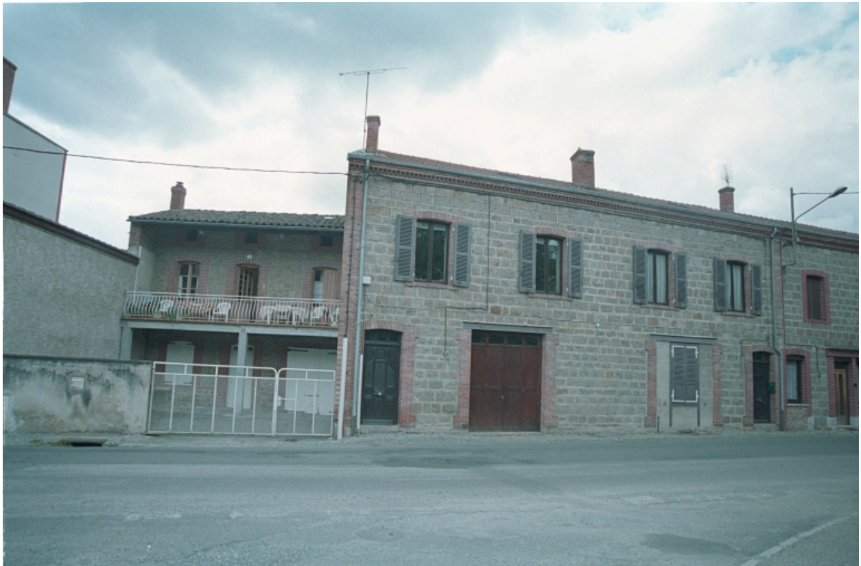
Vue d'ensemble de la façade de la maison depuis la route.
