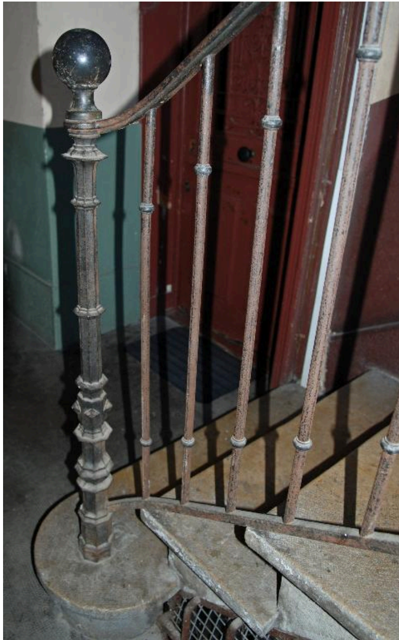
Immeuble sur cour : vue du départ de l'escalier
