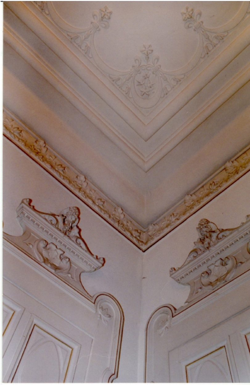
Plafond et dessus-de-porte, 1er étage
