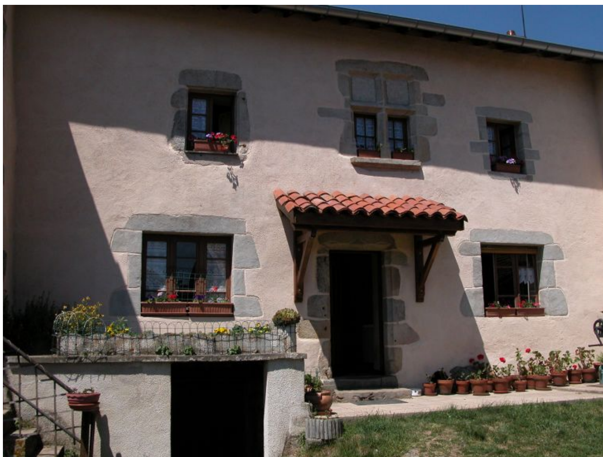
Vue d'ensemble de la façade du logis.
