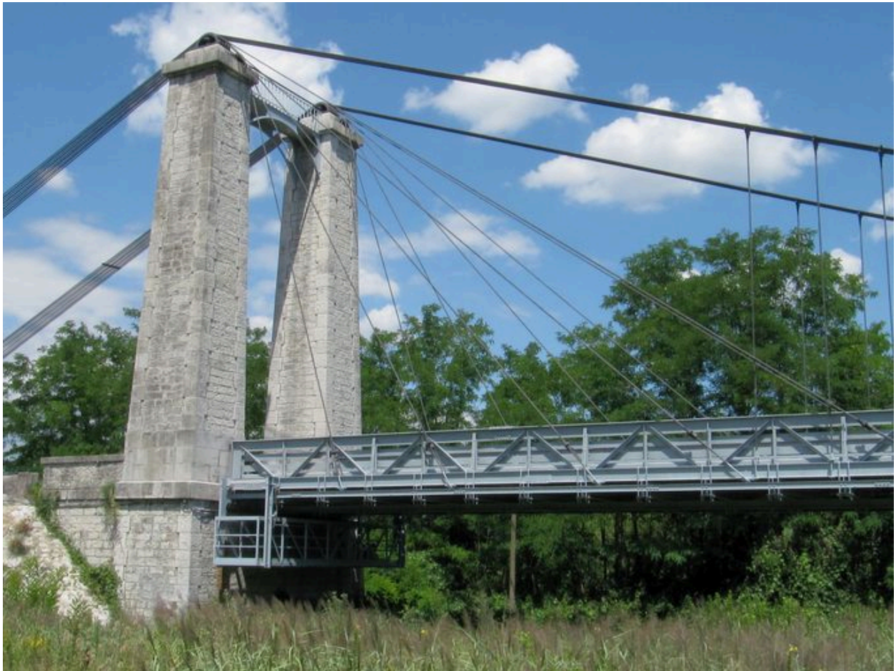
Pylône de la rive droite, face aval
