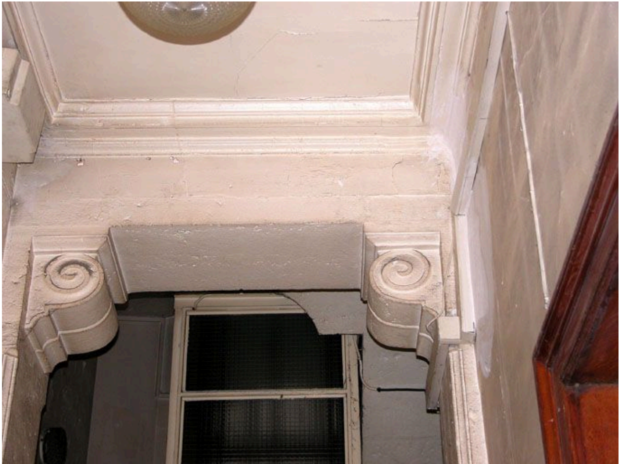
Détail de l'étrésillonement supportant le plafond du vestibule
