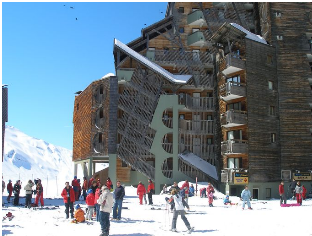
Façade nord depuis le nord-est
