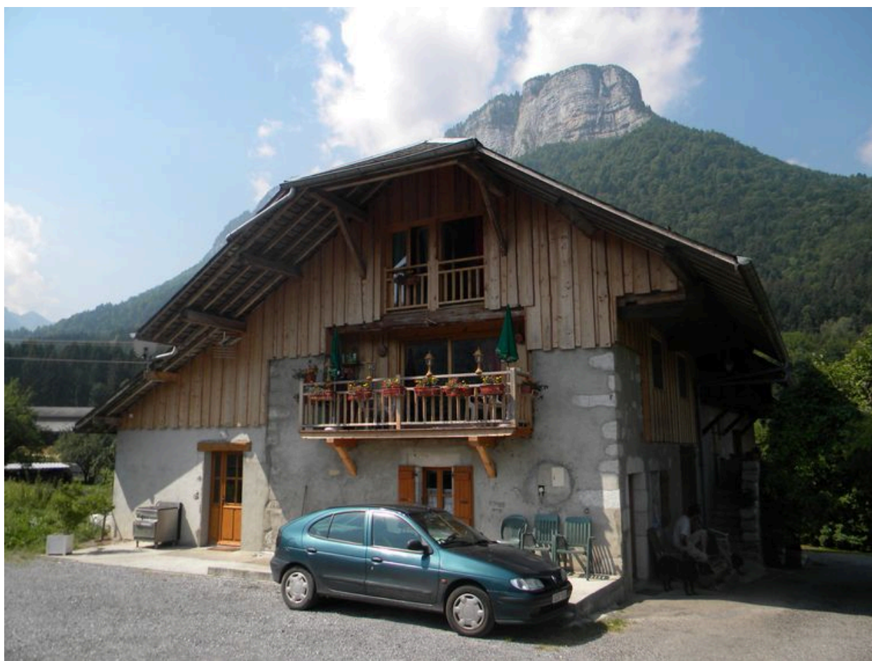
Vue du pignon est.
