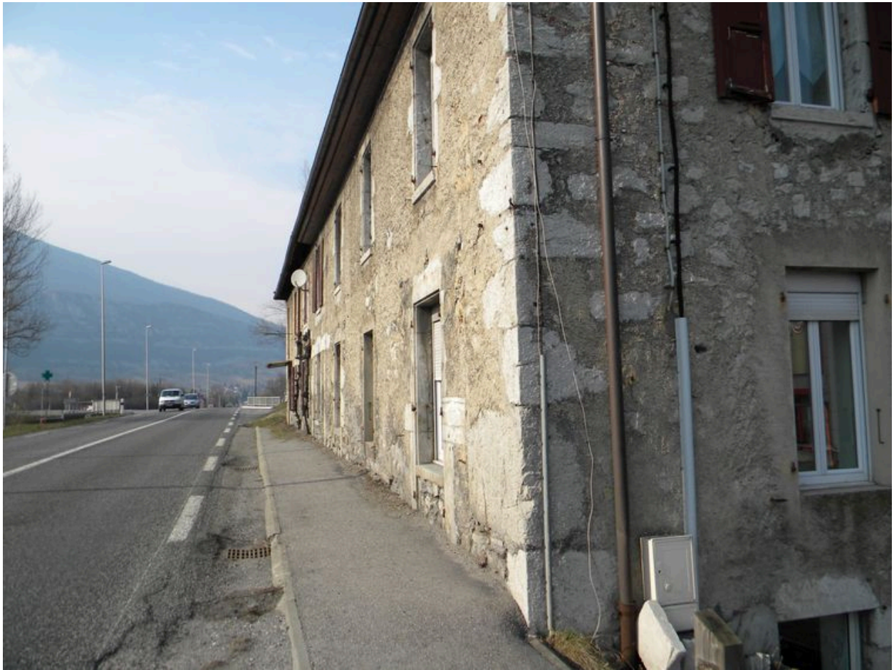
Vue d'un chaînage d'angle en calcaire.
