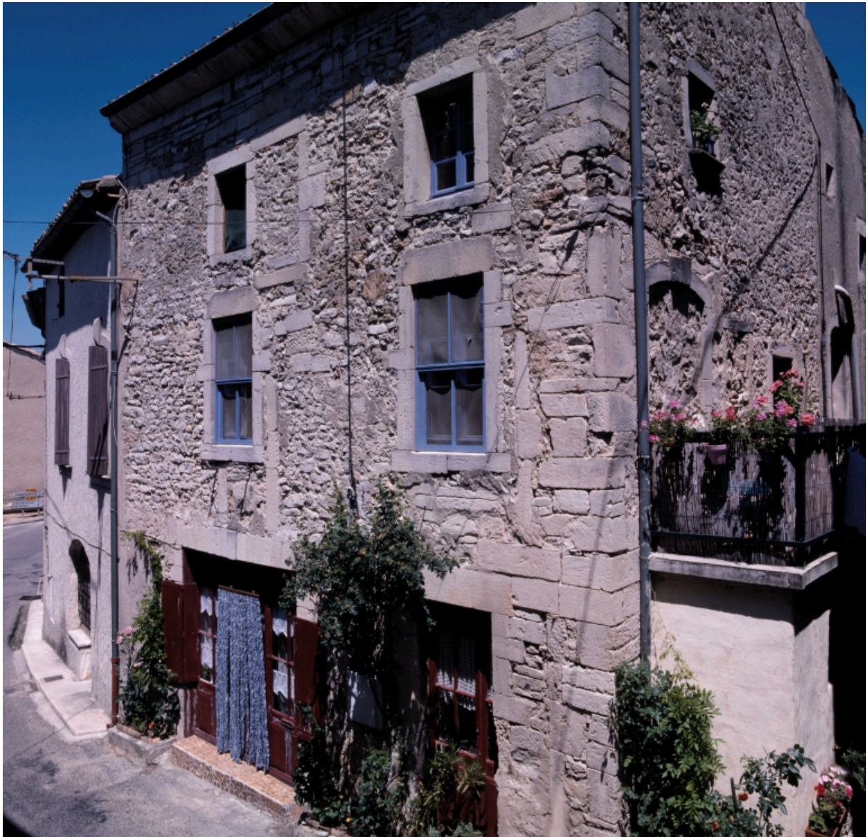
Le Village, Grande rue. Vue d'ensemble de la maison A2 610.
