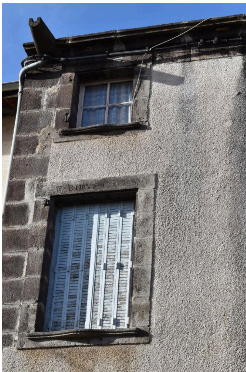
Vue partielle : façade avec date portée sur le linteau et gargouille saillante
