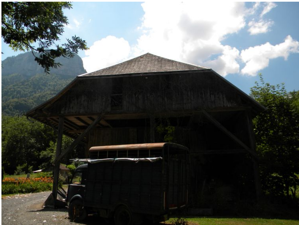
Vue du pignon du côté de la rivière.
