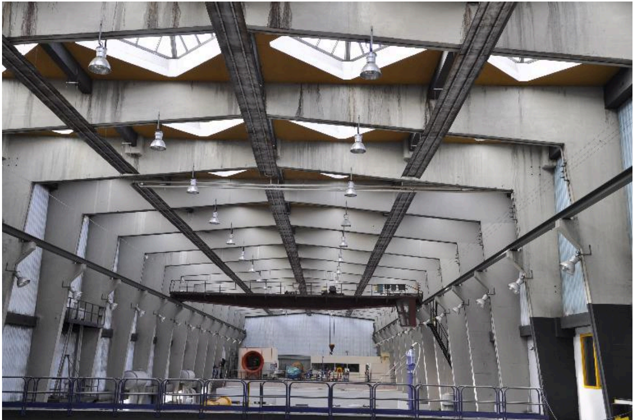
Vue de la charpente en béton de la halle
