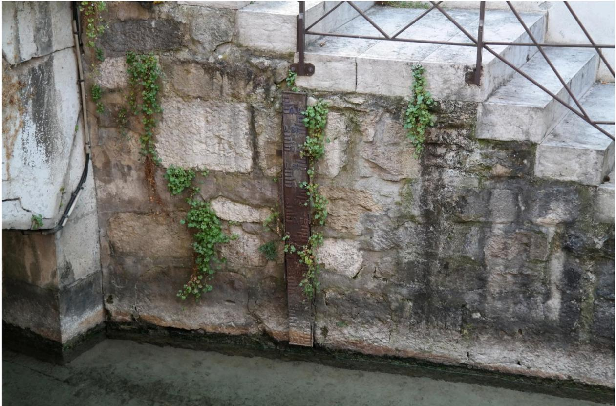
Pont des Cordeliers, echelle de mesure du niveau d'eau
